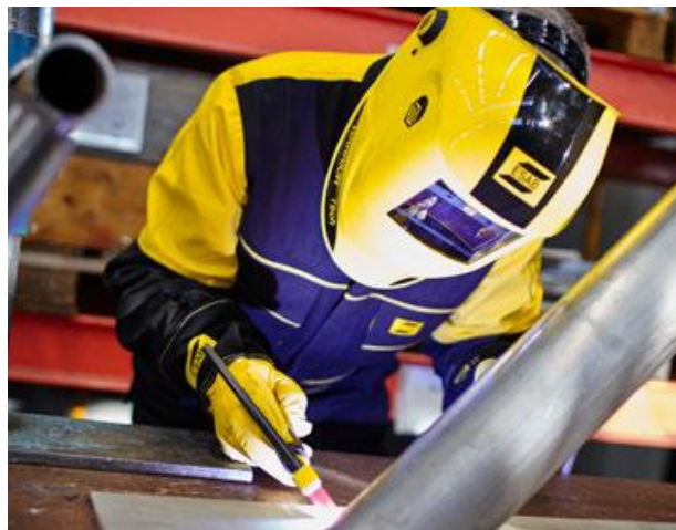
Soldadura proceso TIG
